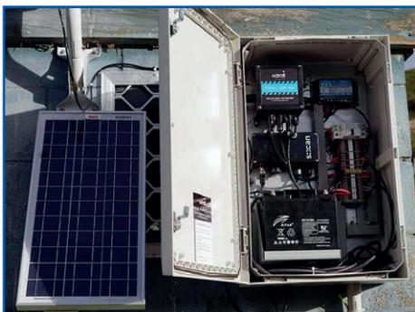
装有数据记录器、传感器控制器、太阳能控制系统和电池的外壳机箱安装在附近泵房的侧面。IP 级外壳机箱是所有传感器电缆和网络连接的端点。它可以安装在墙上或柱子上，具体取决于实际应用现场。
