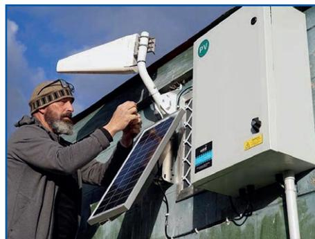
30瓦太阳能电池板安装在建筑物的屋顶上。由于位置偏远，增加了外部定向天线以确保稳定的网络连接。定向天线用于两点之间的中等范围（5至8公里）通信。在此解决方案中，控制箱使用 Cat M1 协议传输到本地网络提供商。
