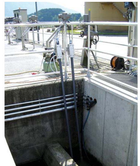
INSTALLATION: ammo::lyser™ und spectro::lyser™ im Zulauf der Kläranlage Bild 2
