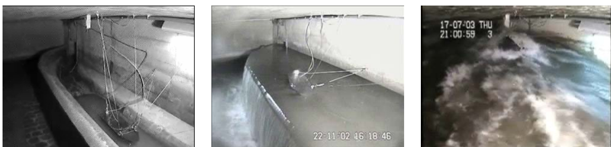
Abbildung 2 Schwimmender Ponton mit dem UV/VIS-Spektrometer an der Kanal-Messstation Graz bei unterschiedlichen Abflussverhältnissen im Kanal
