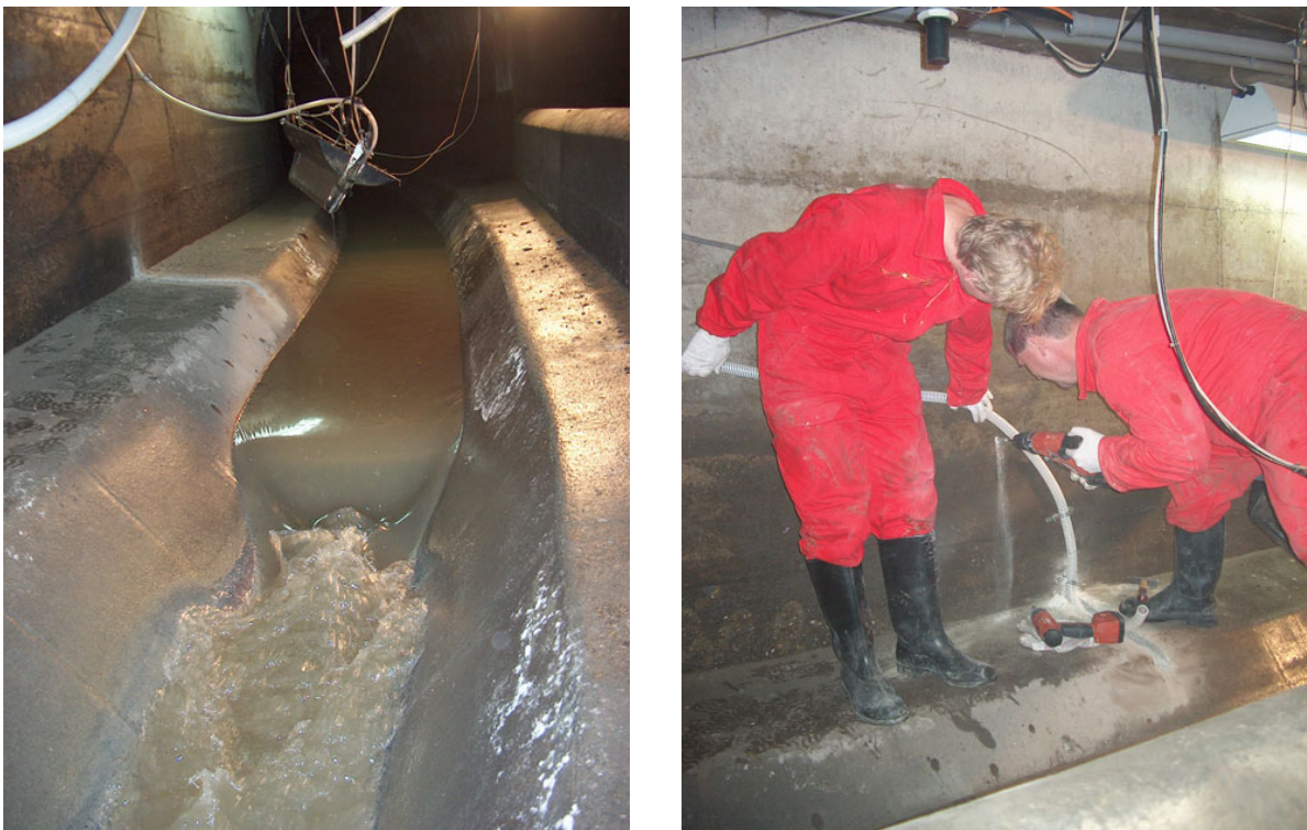
Abbildung 5 Weitestgehend verzopfungsfreie Installationsvariante des Bypass-Ansaugpunktes in Graz durch Einbau eines Staubleches und Einfräsen des Bypass-Ansaugpunktes. Der Ponton befindet sich im linken Bild in Wartungsposition.
