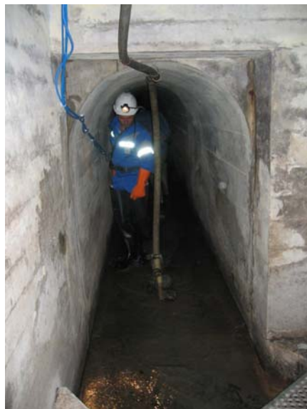
Abbildung 4 Variabler Ansaugpunkt des Bypasses bei der Kanalmonitoring-Messstation in Ecully in Lyon
